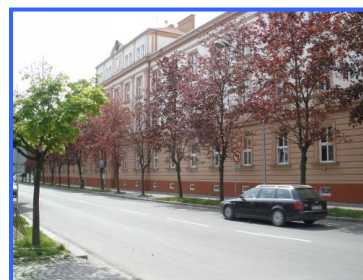
Obr: Kroměříž, Blok L, pohled z ulice
